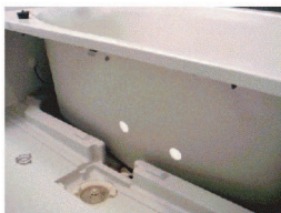
前面のカバーを取り外し浴槽に必要な穴をあけます
