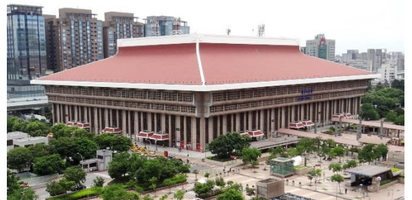
台北駅 外観（提供：台湾鐵路管理局）
