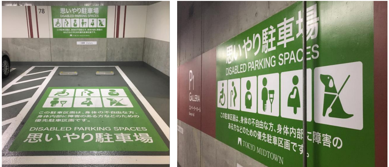
東京ミッドタウンの駐車場（左：床面、右：壁面）
