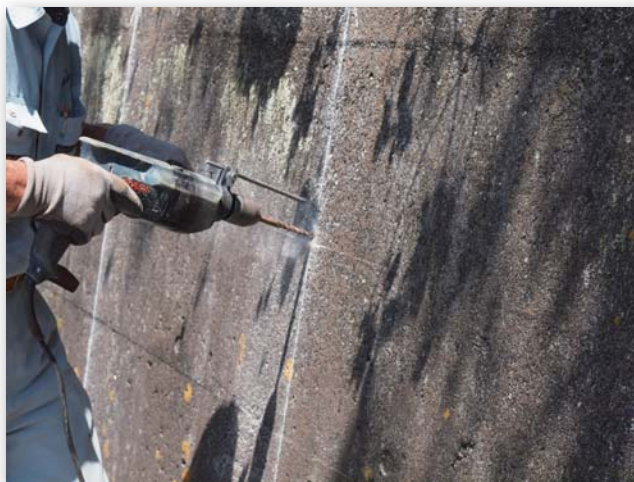
②支柱固定用アンカー穿孔
