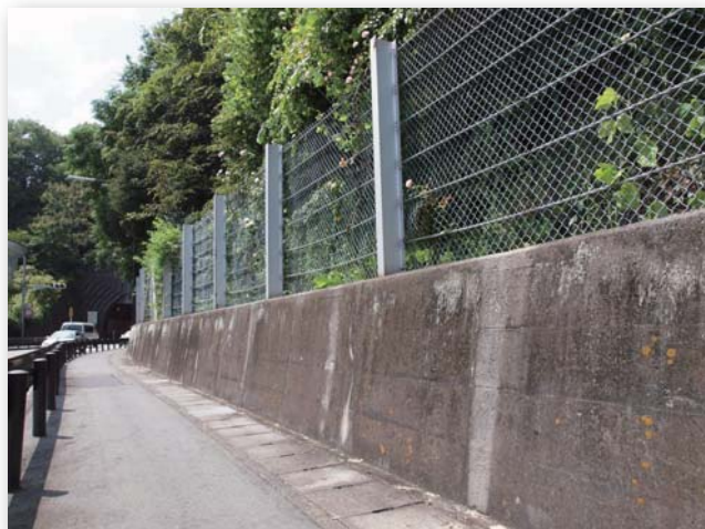
①工事着工前
