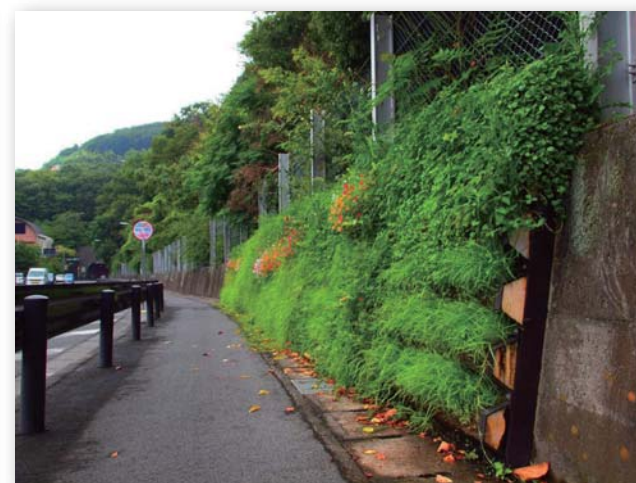
⑥工事終了後、約1年経過状況
