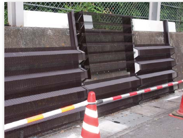
③緑化ユニット取付状況（アクリル塗装）
