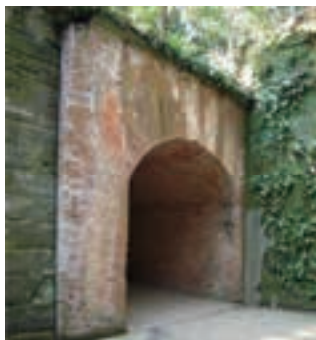
▲フランス積み煉瓦が美しい猿島内のトンネル
