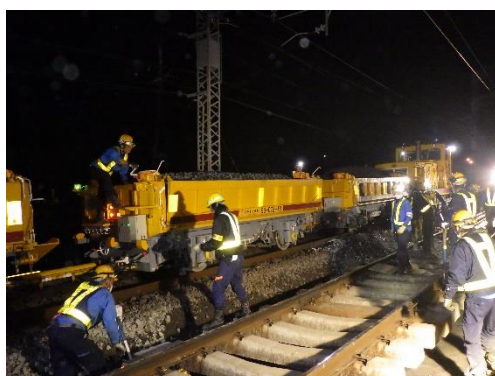
線路保守作業
