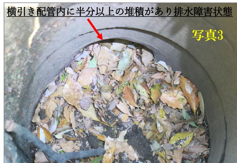
長期間の清掃不良で泥溜まりスペースを超えて乾燥した堆積物があり、排水能力が著しく損失している。
