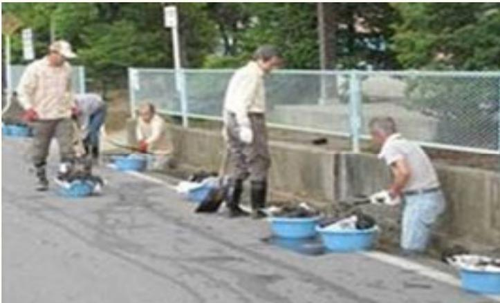
ゴミの流入が排水勾配を悪くし、汚泥化堆積物となり排水障害が起きる。不衛生且つ体力が必要な溝さらい。
