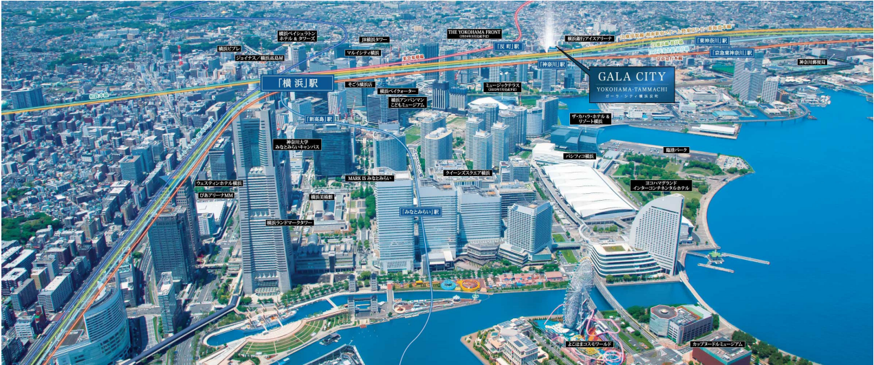
【現地上空からの航空写真】
