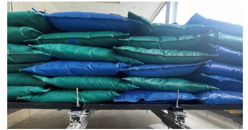
ソーラーパネル及び補強架台の荷重検証風景
