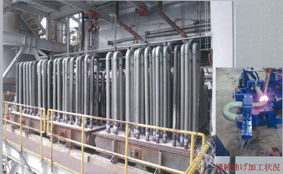
フィン無 BTP 取付状況(ユニット)の一例
