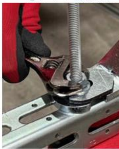
④ナットを適切に締め施工終了
