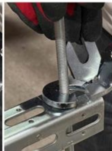
④ナットを適切に締め施工終了
