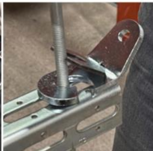
④ナットを適切に締め施工終了
