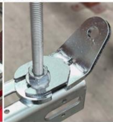
④ナットを適切に締め施工終了
