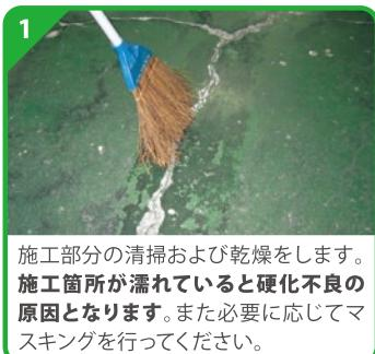
施工部分の清掃および乾燥をします。施工箇所が濡れていると硬化不良の原因となります。また必要に応じてマスキングを行ってください。
