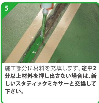
施工部分に材料を充填します。途中2分以上材料を押し出さない場合は、新しいスタティックミキサーと交換して下さい。
