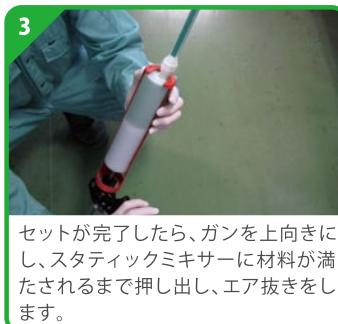
セットが完了したら、ガンを上向きにし、スタティックミキサーに材料が満たされたるまで押し出し、エア抜きをします。
