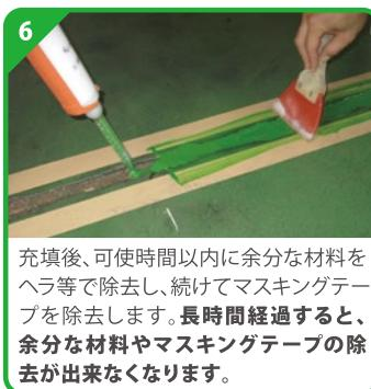
充填後、可使時間以内に余分な材料をヘラ等で除去し、続けてマスキングテープを除去します。長時間経過すると、余分な材料やマスキングテープの除去が出来なくなります。
