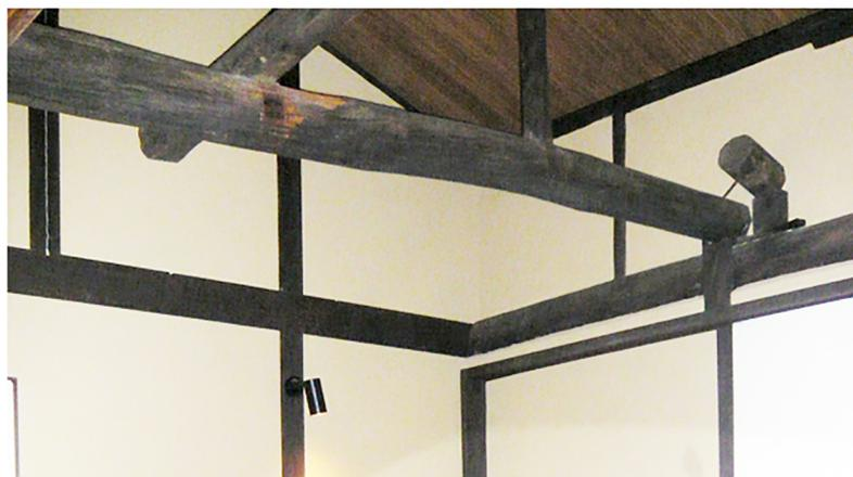
宮大工による京町屋古材 梁組施工！
